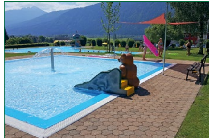
Das sanierte Kinderbecken im Freibad Kirchbach
