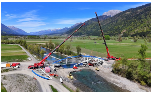
Montage Stahlbau Frühling 2026
